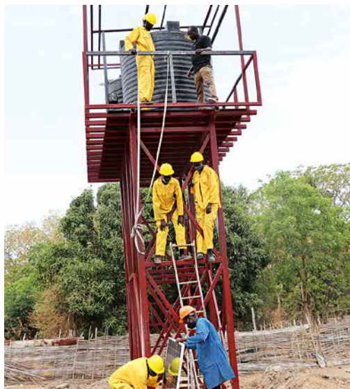
▲ SOLÁRNE PANELE POHÁŇAJÚ VODNÉ ČERPADLO, KTORÉ POČAS DŇA NAPLNÍ VODOU DVE NÁDRŽE S OBJEMOM 10 HL. STAČÍ UŽ LEN PRÍSŤ A OTOČIŤ KOHÚTIKOM. DETI A ŽENY UŽ NEMUSIA KRÁČAŤ KILOMETRE A HODINY PEŠO. NAMIESTO TOHO MÔŽU CHODIŤ DO ŠKOLY.
